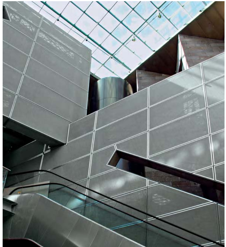
Die großflächige Wandverkleidung in der National Gallery of Victoria in Melbourne besteht aus nichtrostendem Stahlgewebe, das in umlaufende Rahmen gespannt ist.
