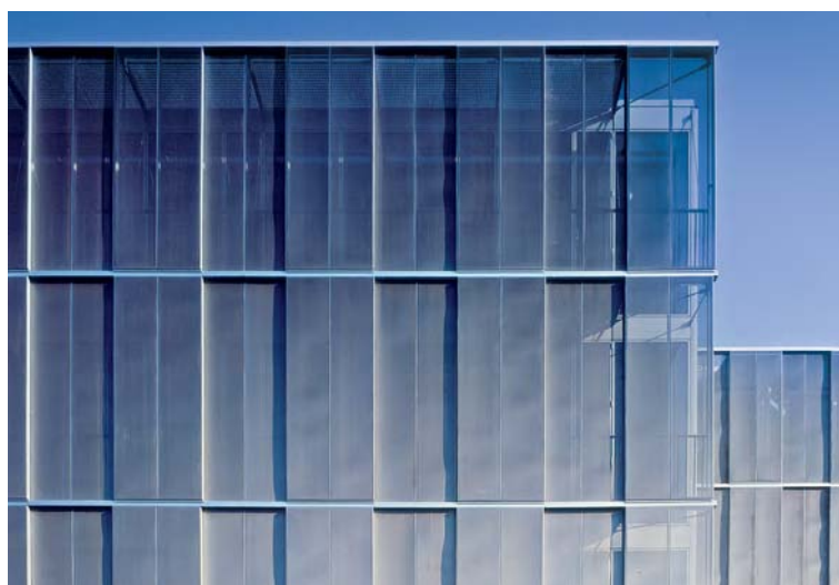
Die Flexibilität im Inneren der Häuser spiegelt sich in der Fassade wieder. Durch den Wechsel aus feststehenden und verschiebbaren Streckmetallelementen ändert sie sich mit den individuellen Bedürfnissen der Benutzer.
