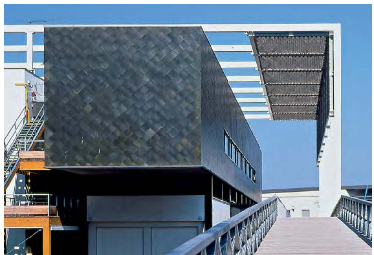
Der Sonnenschutz an der Mediathek im französischen Sélestat besteht aus geschweißten Edelstahlrosten.
