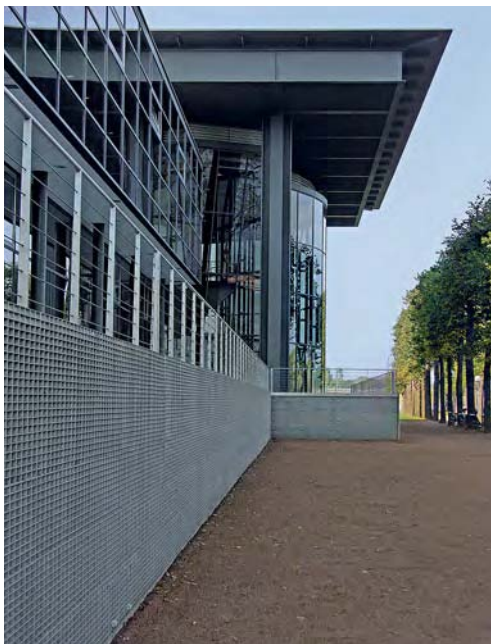
Am Sächsischen Landtag in Dresden ist der dem Elbufer zugewandte Betonsockel mit Gitterrosten verkleidet.
