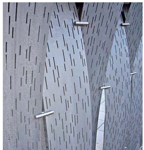
Gebogene nichtrostende Stahlbleche mit unregelmäßigen, laser-geschnittenen Schlitzten bilden den lichtdurchlässigen Sichtschutz im Bereich einer Polizeistation am Karlsplatz in Wien.
