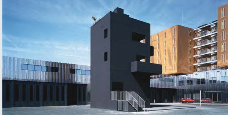
Die mit nichtrostenden Trapezblechen umhüllte Feuerwache bildet den Sockel für die Wohnbebauung an der Stirnseite der U-förmigen Anlage.
