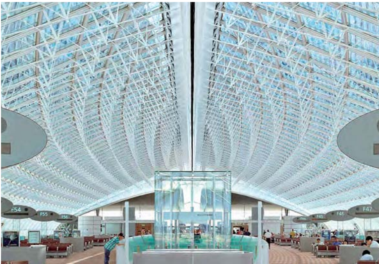
Im Pariser Flughafen Charles-de-Gaulle bilden 68 mm hohe, gelochte Trapezbleche aus nicht- rostendem Stahl den außenliegenden Sonnen- schutz der verglasten Abflughalle.
