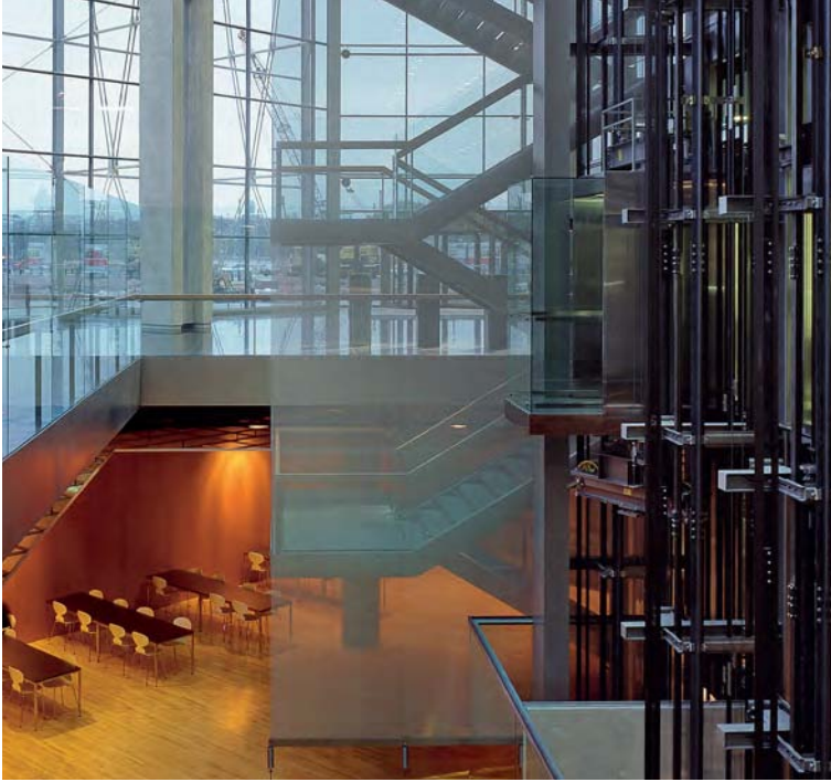
Eine über neun Geschosse durchlaufende Gewebbahn bildet die Absturzsicherung der Treppe im Atrium des Sanoma Gebäudes in Helsinki.
