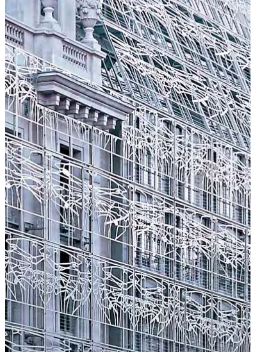
Wie ein Schleier legen sich die aus 12 mm dicken nichtrostenden Stahltafeln laser-geschnittenen Ornamente über die verschiedenen Gebäudeteile des Ministeriums für Kultur in Paris.
